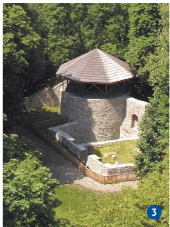
Rekonstrukcja wieży ostatecznej obrony ↑
